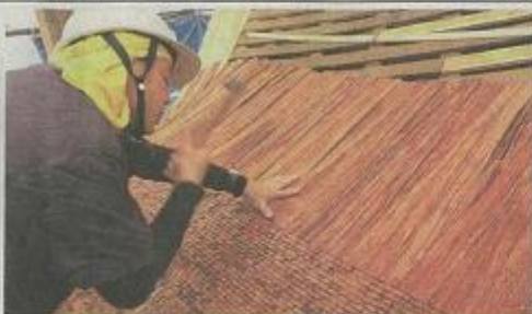
映画「Connect」で檜皮葺きのふきかえ工事を する職人＝岡部さん提供
